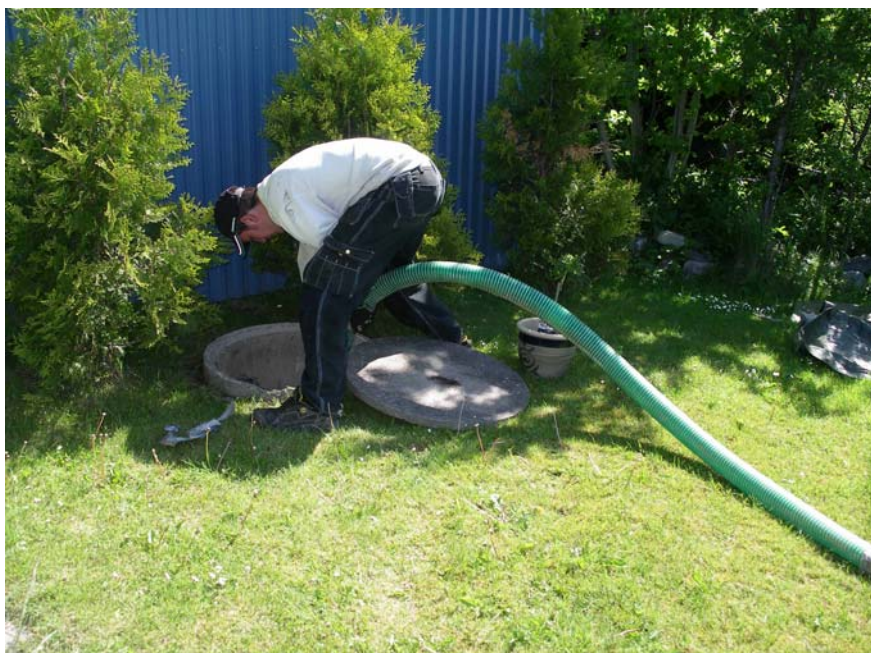
Bild 5. Många urinbrunnar behövs för att tillgodose gårdens näringsbehov. Andreas kopplar slangen till en urinbrunn i Hamburgsund.
