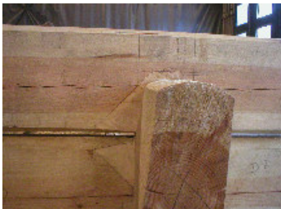
Här ser man hur mycket stocken ska sjunka och långdraget ritas med passare
