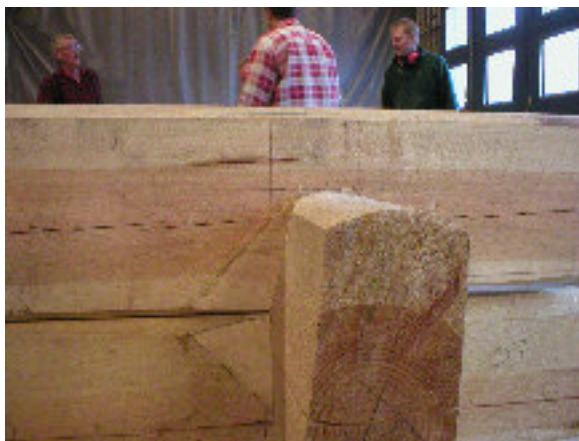
Efter justeringar av halsspåren ligger stocken på plats
